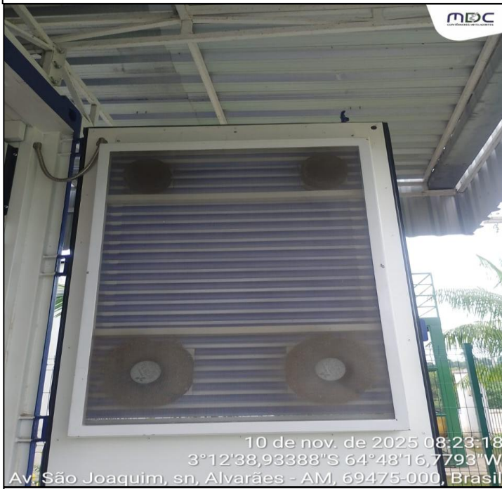
Condição inicial dos filtros , apresentando acúmulo significativo de sujeira antes do processo de limpeza.
