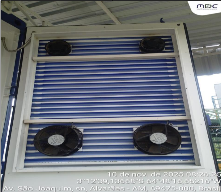
Ventiladores , apresentando condições adequadas de operação.
